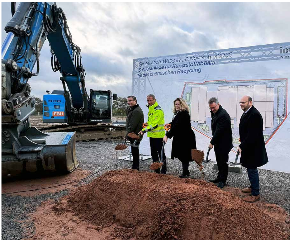
Spatenstich für die neu entstehende Anlage in Walldürn
